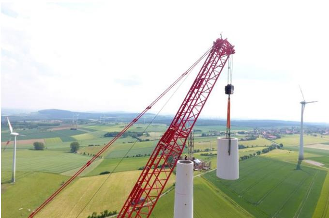
Stück für Stück wird hier der Turm zerlegt. Auch Rotorblätter, Gondel und Fundament werden einzeln zurückgebaut und verwertet. Viele Bestandteile lassen sich recyceln. (Foto: Hagedorn Abbruchservice GmbH)
